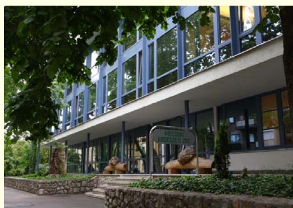
2. ábra – Központ épülete - Pécs
